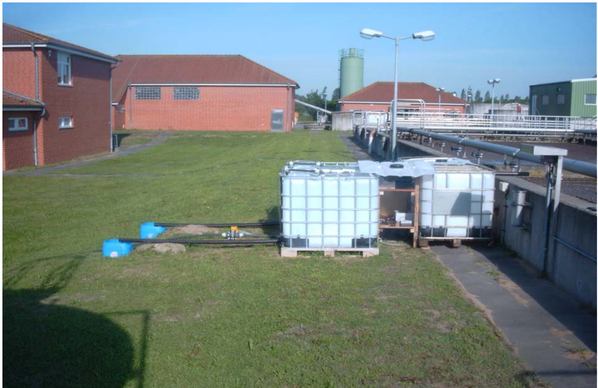
Abb. 1: Versuchsanlage auf der Kläranlage
